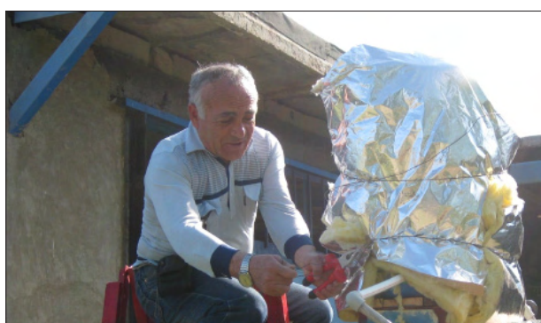
Шаг 7. Изолируйте бак и трубы
