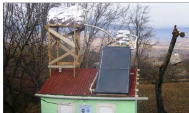
Шаг 8. Наполните коллектор незамерзающей жидкостью
