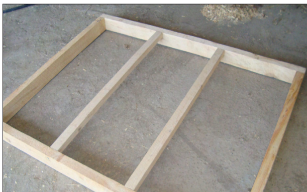
Шаг 2. Скрепите между собой стороны брусьев
