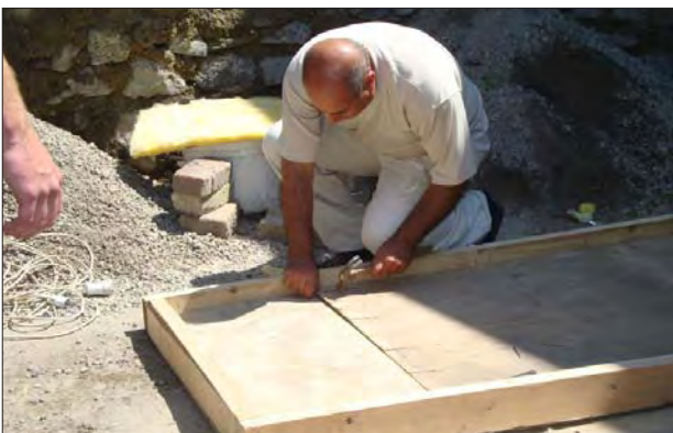
Шаг 5. Укрепите фанеру на верхнюю часть рамы, покрасьте черной, матовой краской
