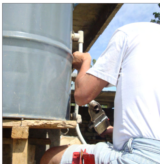
Шаг 6. Подсоедините теплообменник к коллектору (верхняя часть: вход воды, нижняя часть: выход воды) и бак к системе водоснабжения (нижняя часть: вход холодной воды из резервуара или системы водоснабжения; верхняя часть: выход теплой воды к потребителю)
